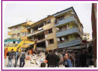
Desteli yana çökmüş bina
